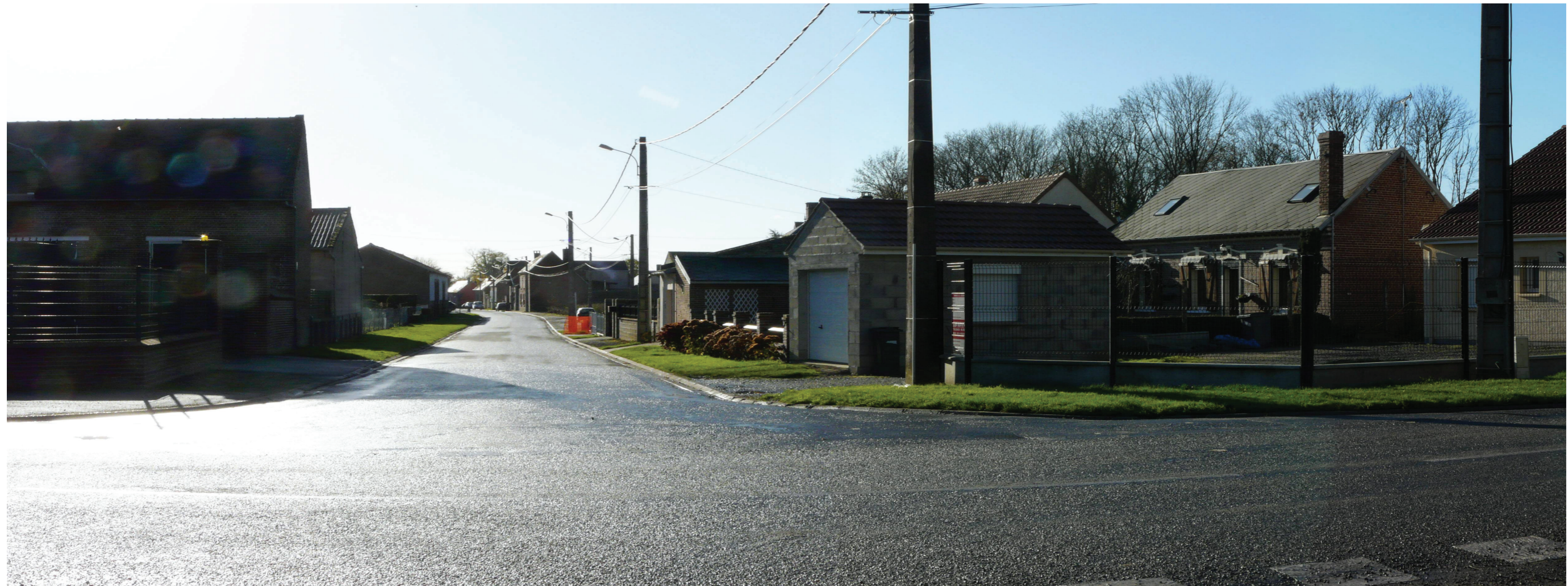
Photographie état initial - panorama à 60°
